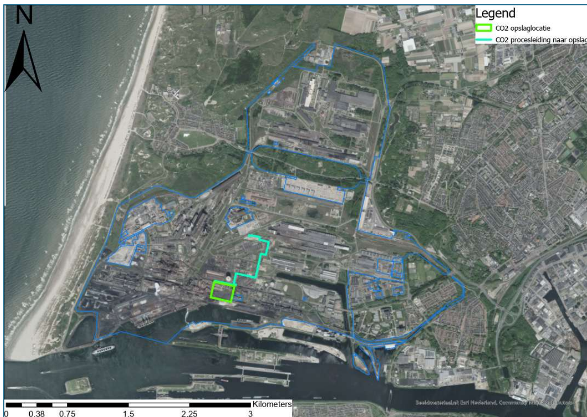
Figuur 7.2. Locatie CO 2 opslagtanks en loop van toevoerende leiding
